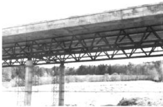
پل شبکه دو لایه Lully viaduct در کشور سوئیس
