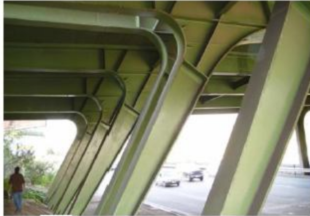
اتصالات خمشی زانویی
