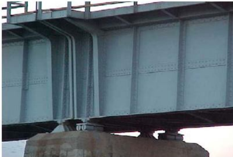
تکیه گاههای غلتکی و مفصلی پایه میانی (Fix, Free)
