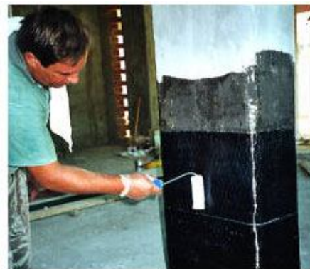
تقویت مقاومت خمشی با استفاده از سیستم FRP
