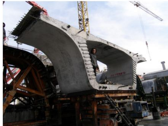
تولید قطعات به روش درز مزدوج (Match Cast)
