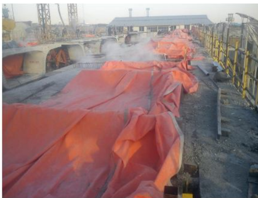
عمل آوری قطعات بتن ریزی شده با بخار
