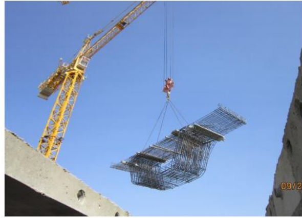
انتقال سبد بافته شده به داخل قالب ها
