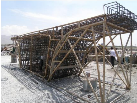
آرماوربندی هر قطعه با به کارگیری شابلون مخصوص
